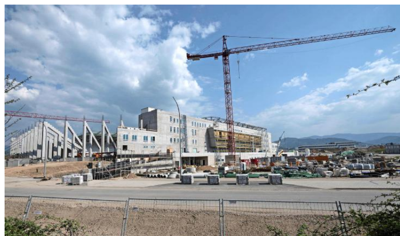
Für 76 Millionen Euro entsteht das neue Stadion des SC Freiburg. Allerdings muss Rücksicht auf die Anwohner genommen werden. FOTO: DP/PAATRICK SEEGER
